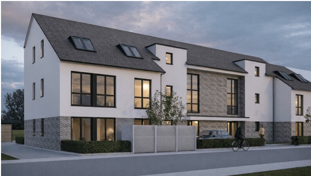
6365_Stürzelberger Straße 36_Gebäudevorderseite
