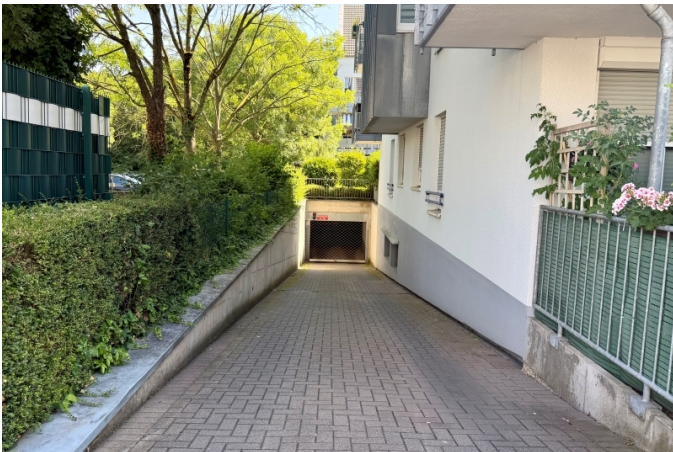
6381_Unter den Hecken 86_Tiefgarageneinfahrt
