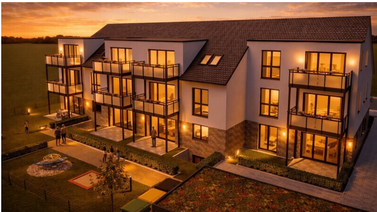
6359_Stürzelberger Str. 36_Neubauprojekt Mehrfamilienhaus
