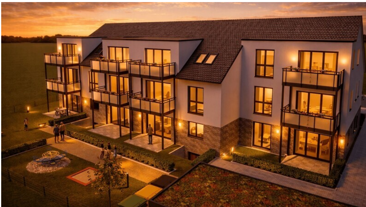
6358_Stürzelberger Str. 36_Neubauprojekt Mehrfamilienhaus
