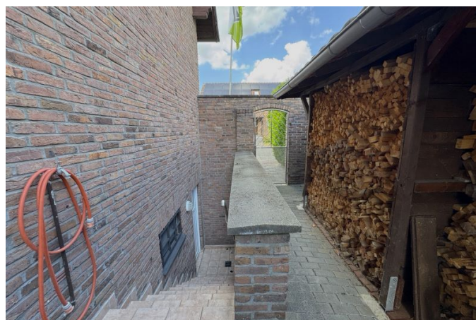
Im Merheimer Lehm 11_Kelleraußentreppe und Gartentor
